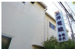
新設された第2工場
