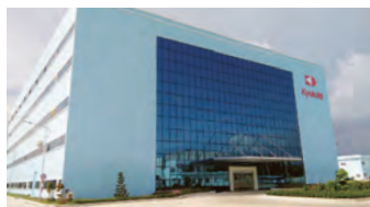
平成29年完成のベトナム工場
