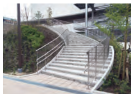
ステンレス製螺旋階段の手すり
