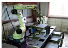
ロボット溶接機
