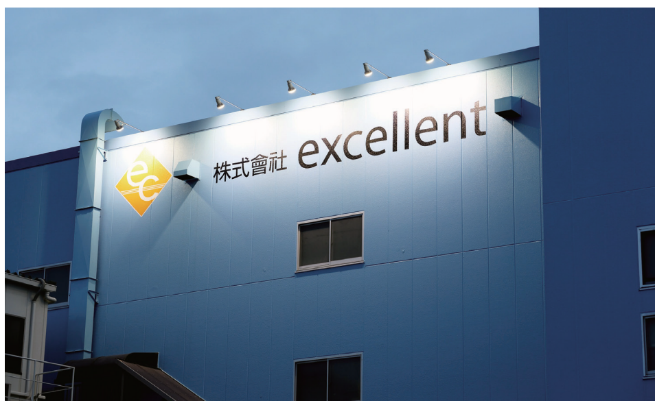
本社・工場の外観
