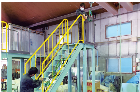
階段の寸法検査。検査確認を徹底
