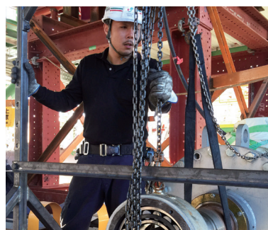
発電施設の機器メンテナンス工事
