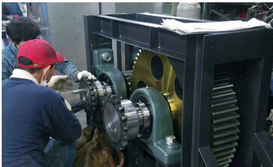
架台製作（組入作業）
