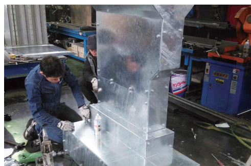
ケーブルダクト製作
