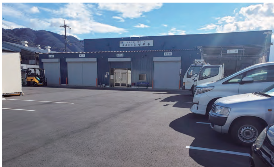
同社工場は溶接・製缶・塗装・組立の一貫受注に対応
