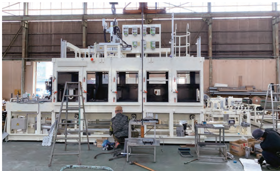
洗浄装置の組込作業
