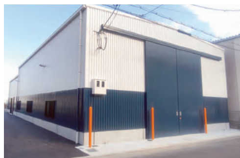
第二工場はロボット開発専用工場として稼働
