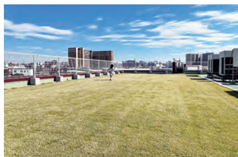
本社社屋の屋上緑地
