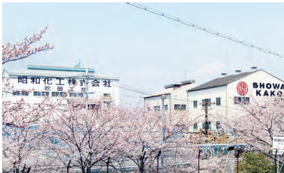
大阪府吹田市の本社社屋
