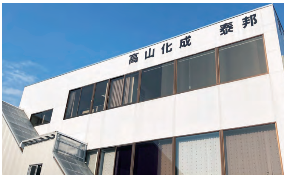
大阪府八尾市に構える本社建物
