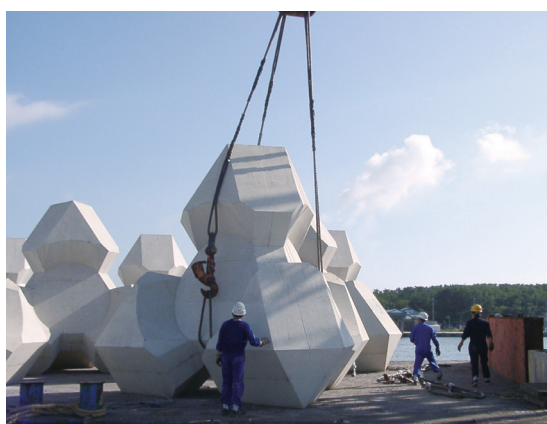
80tのテトラポットの吊り上げ作業に使われるワイヤロープ「きわみ」
