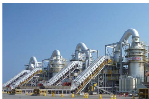
エプロンコンベヤでガレキ処理
