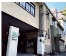
社屋には老舗の趣がある
