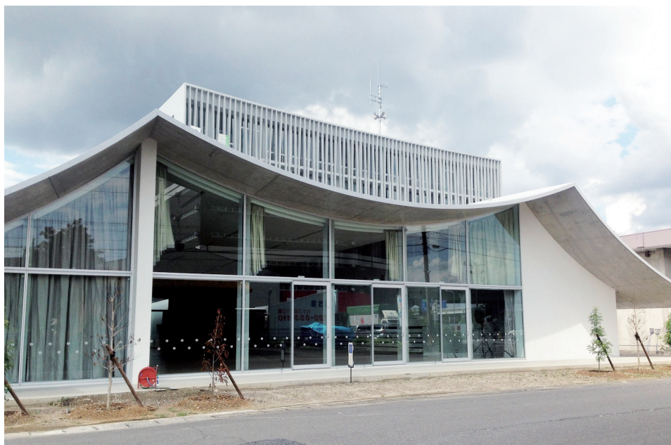
岐阜県庁舎（岐阜県）の大型屋根の建設にも貢献
