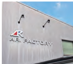
八尾市内に拠点を構える本社
